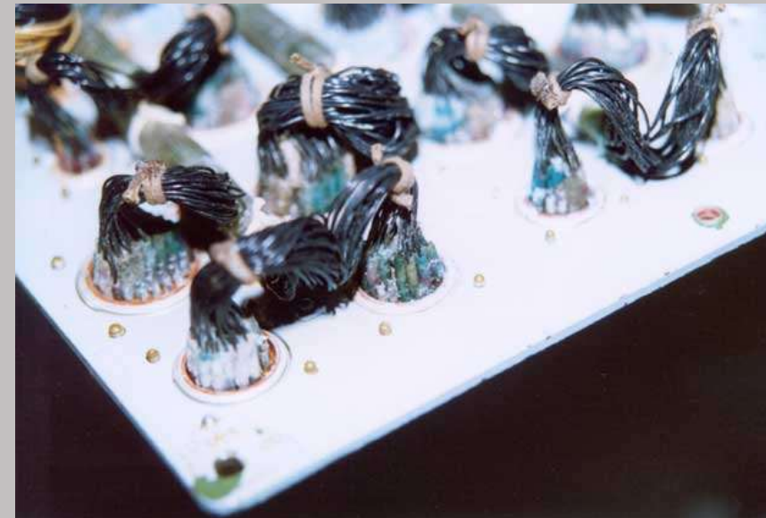
Поврежденная плесенью изоляция проводов на станции "МИР" (ИМБП РАН)
